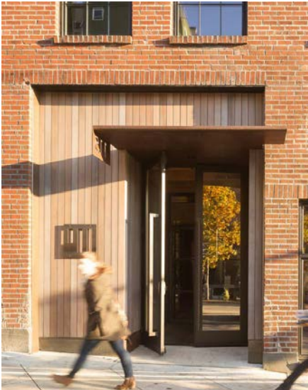
Skärmtak och träpanel runt entrépartier runt bostadsentréer.
