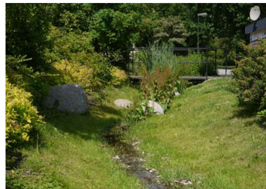
Dike i gräsyta fungerar fördröjande av dagvatten och skyfall. Foto: cc by Trädkontoret
