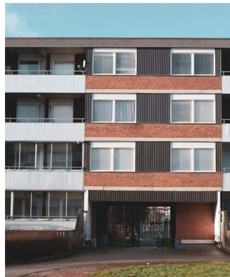
Platt tak med krönplåt vid tak och täta balkongräcken
